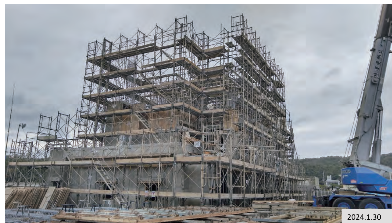
汀間漁港製氷施設整備事業建築工事(沖縄県 名護市) RC造4階 延床面積約498㎡ 重塩害地域にて塩害対策として採用。
